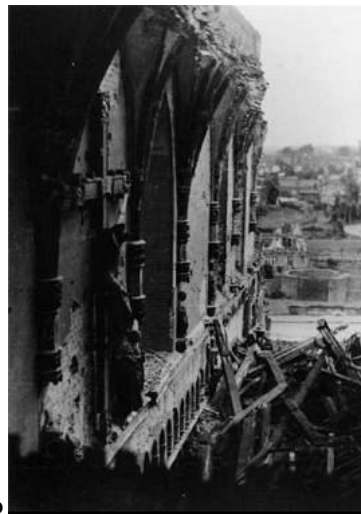
Rys. 10 a, b. Wschodnia część kościoła NMP na zamku krzyżackim w Malborku. Na fotografii archiwalnej z ok. 1930 roku stan chóru regotyżowanego w wyniku prac Konrada Steinbrechta (a). Na Rys. b stan z około 1950 roku po zniszczeniach wojennych, gdy runęło sklepienie i część wschodnia kościoła. Fot. Archiwum fotograficzne MZM
