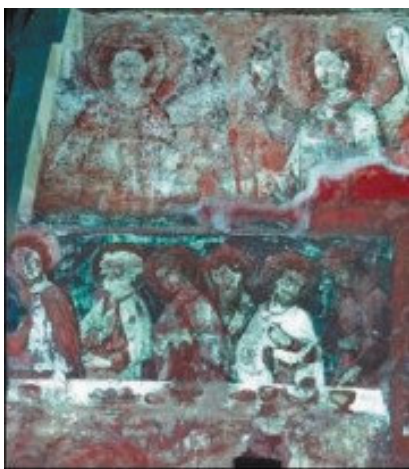
Rys. 11 a, b, c. Fragment malowideł na południowej ścianie kościoła zamkowego w Malborku. Stan z 2004 roku (a), fot. A. Skowroński. Fotografia w UV uczyniła zniszczenia warstw malarskich oraz zakres przemalowań konserwatorskich głównie tła i szat postaci (b), fot. A. Skowroński. Badania termograficzne potwierdziły miejsca występowania zniszczeń - w ubytkach tynku widoczna duża emisyjność podłoża oraz wskazały charakterystyczne pigmenty opracowania malarskiego, przykładem płaszcz Chrystusa. Fot. B. Więcek
